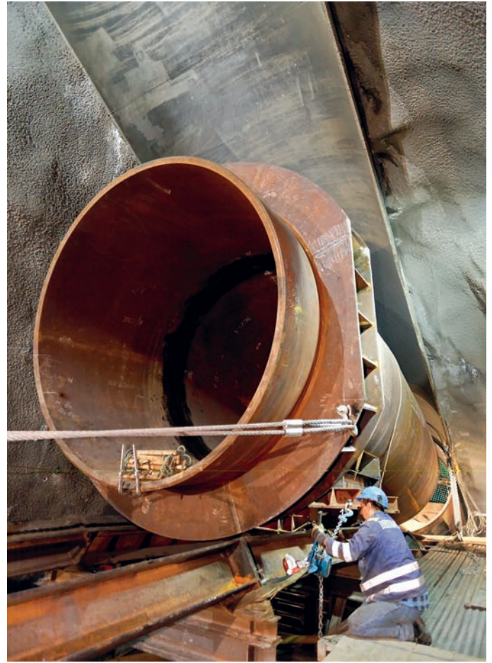
Abb. 3: Anschluss der waagerechten Druckleitung an den bestehenden Druckschacht am Ende des unteren Zugangsstollens (Foto: Michael Martinez, Sion)
